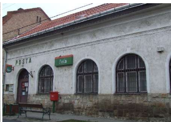
14. Posta Bolt utca 15. hrsz.: 1508
